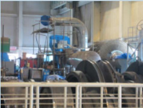
Gambar 7 : Turbin unit 2 sedang dalam perbaikan
