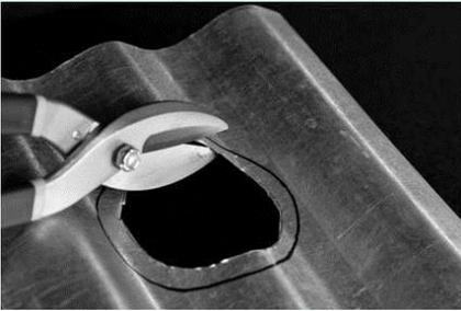
Langkah 3: Jarak 1 cm tersebut dipotong membentuk strip dan ditekuk ke atas tegak lurus dengan lembar GI.
