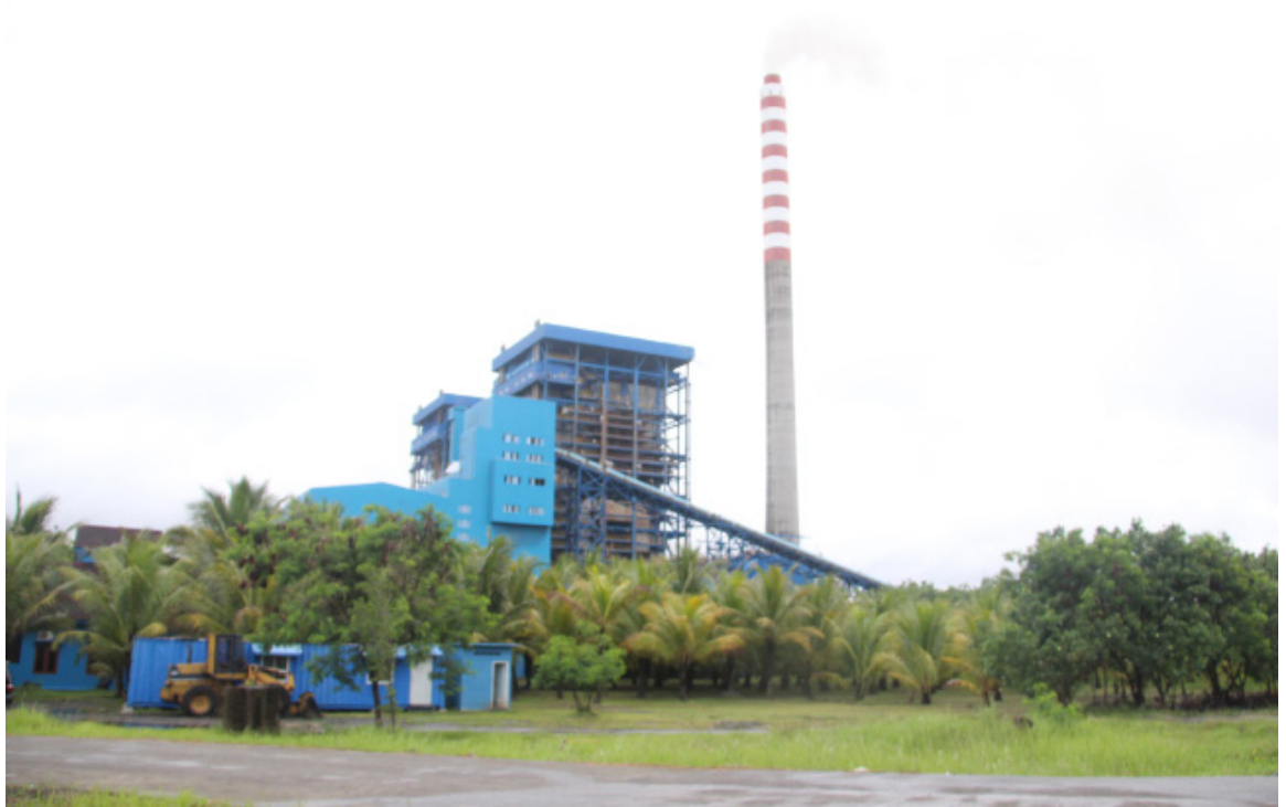
PLTU Cilacap yang dikelola oleh PT. Sumber Segara Primadaya (S2P) berkapasitas 300 MW. PLTU ini juga tengah membangun PLT Ekspansi 600 MW yang direncanakan dapat masuk ke sistem kelistrikan tahun 2016.
