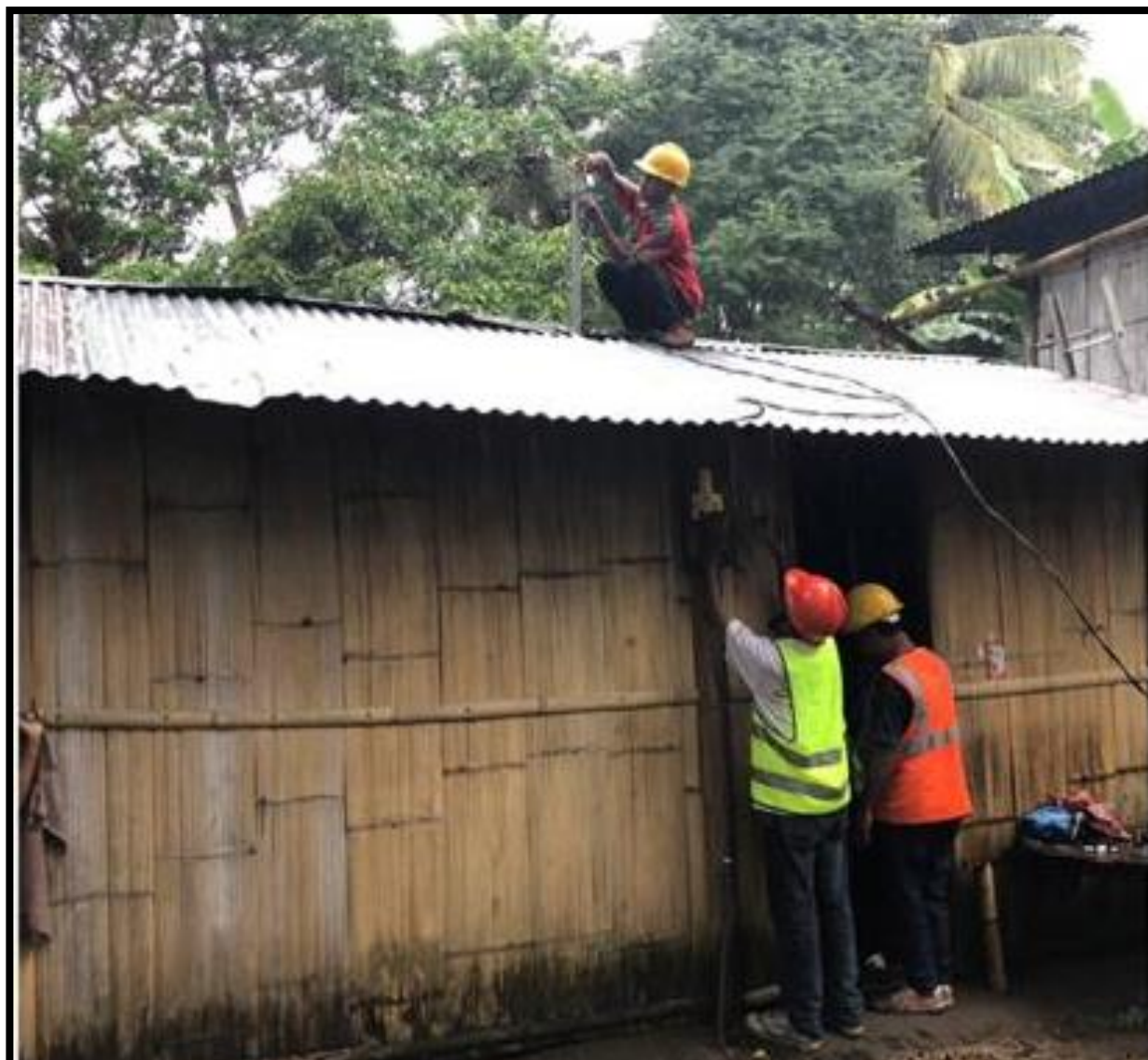
Pemasangan kWhmeter & SR
