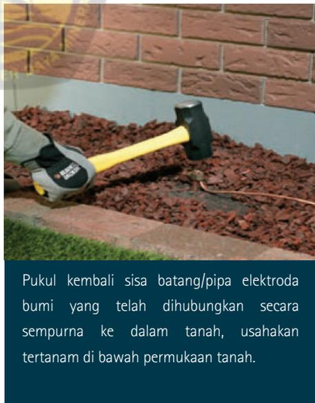
Gambar pemasangan elektrode bumi
