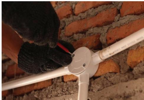
Pemasangan kotak sambung pada instalasi yang menggunakan konduit.
