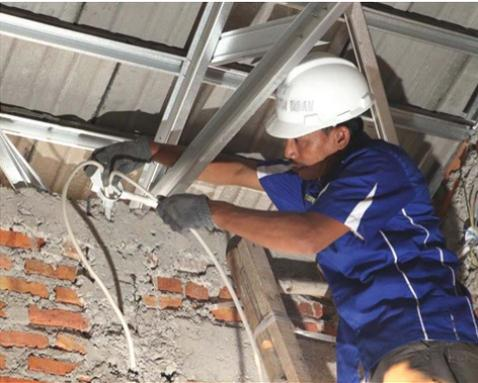
Untuk kabel NYM yang ditanam kedalam beton harus dilindungi dengan conduit PVC, hal ini sesuai dengan persyaratan PUIL 2011, Tabel A.52.3 Nomor urut 60.
