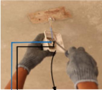
Koneksi kabel dengan terminal fitting sesuai penanda polaritas yang dilakukan dengan *multimeter*, pastikan kabel terkoneksi dengan baik pada *Screw fitting*.
