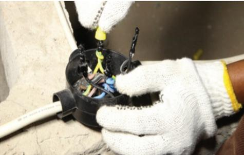
**Gambar 6.47**– Setelah dilakukan penyambungan puntir harus diisolasi dengan pita insulasi minimal 3 lapisan dengan ketentuan bagian konduktor nya tertutup sempurna
