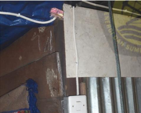
Untuk kabel NYM yang ditempel pada dinding di rumah diberi klem kabel dengan jarak sesuai dengan Tabel I.52.1
