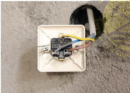
Tampilan outlet kotak kontak setelah dihubungkan dengan kabel.
