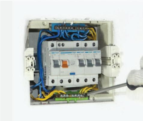
Pasang kabel pembumian pada blok terminal sisi bawah.
