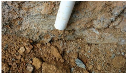
Sebelum konduktor pembumian ditanam kedalam beton ada baiknya dimasukkan kedalam conduit, sehingga memudahkan mengganti kabel jika dikemudian hari terkait pengembangan sebuah instalasi.
