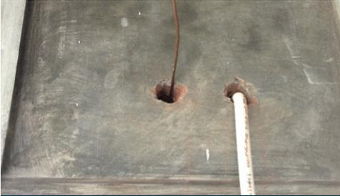
Ujung konduktor pembumian hendaknya ditempatkan berdekatan dengan kabel lin utama sehingga memudahkan saat menghubungkan ke meter kWh.
