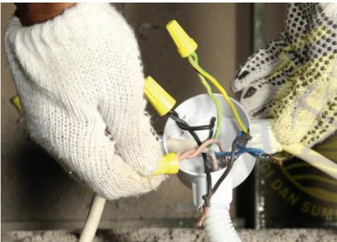
Tutup semua sambungan puntir dengan pita insulasi dan pasang lasdop. Kemudian runut kabel hasil sambungan melingkari sisi terluar di dalam bagian kotak sambung serta usahakan kabel fase terpisah jauh dengan kabel netral.
