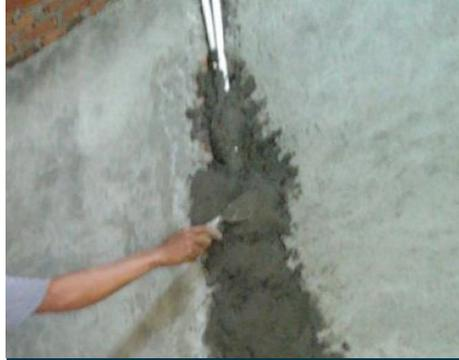
Pemasangan conduit pada bangunan yang telah diplester dapat dilakukan asalkan setelah conduit ditanam bagian yang telah rusak harus diplester ulang sehingga estetika bangunan tidak rusak.
