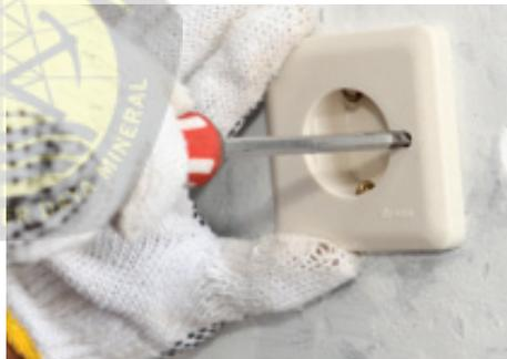
Saat dilakukan pemasangan outlet kotak kontak pada beton yang harus disesuaikan dengan: **134.1.10.6 MOD** (2.5.2.6) Kotak kontak fase tunggal, baik yang berkutub dua maupun tiga harus dipasang sehingga kutub netralnya ada di sebelah kanan atau di sebelah bawah kutub voltase.
