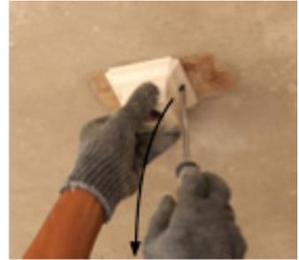
Pasang fitting pada plafon rumah, untuk fitting yang dipasang pada cor-coran lantai sebaiknya pada saat penginstalan konduit sebelum pengecoran ujungnya di klaim dengan kayu yang telah dibentuk hal ini untuk memudahkan saat pemasangan fitting di kemudian hari.
