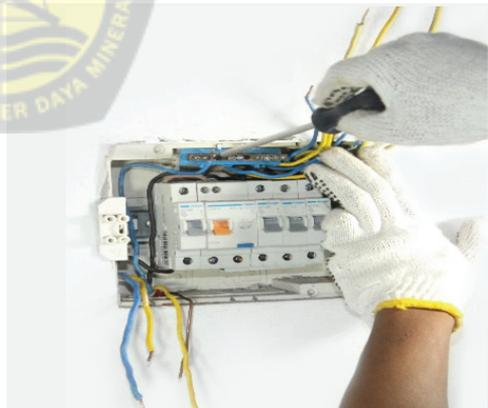
Pasang kabel netral pada blok terminal sisi atas (warna kabel netral harus biru).
