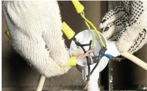
**Gambar 6.48** – Pemasangan lasdop wajib dilakukan pada tiap sambungan puntir.
