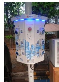
SPKLU R2 UP3 Bekasi 6 slot (3500 watt per slot)
